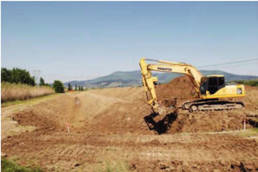
**Figura 28** Il nuovo tratto del canale Garille all'interno dell'Oasi WWF Stagni di Focognano. Il canale, precedentemente caratterizzato da fondo e pareti verticali in cemento (si veda Fig. 2) , è stato completamente rinaturalizzato nel 2011 (Progetto: WWF – Comune di Campi Bisenzio – Consorzio di Bonifica) per evitare ogni possibilità di caduta e morte delle specie durante il passaggio da una sponda all'altra. (per gentile concessione dell'Archivio WWF Toscana – Foto C. Scoccianti – Anno 2011)
