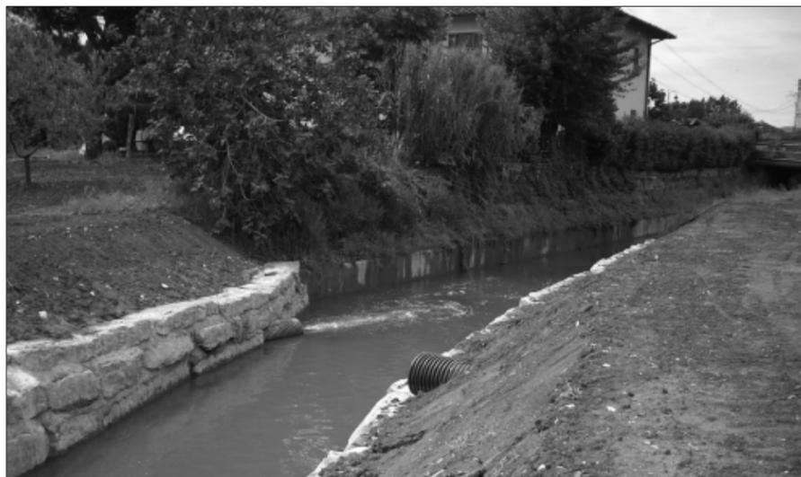
Sono terminati i lavori per spostare un tratto del canale Vecchio Garille, per una lunghezza di circa 580 metri. I lavori sono diventati necessari dopo i gravi danni alle sponde provocati dalle piogge straordinarie dell'inverno 2008 e 2009, nel tratto compreso tra l'attraversamento della strada provinciale Pratese e quello della via di Focognano. Il progetto ha però dovuto tenere
